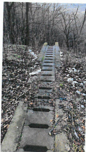
Fotografiile nr. 6 și 7 Imagine de la vizita tehnica (rigolă carosabilă degradată și ravenare)
