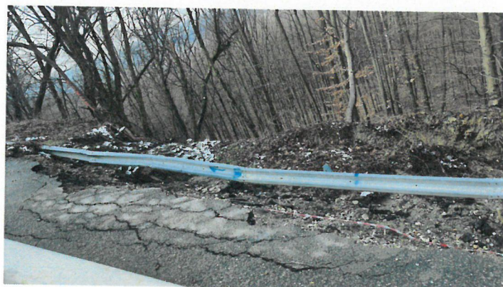
Fotografia nr. 3 Imagini de la vizita tehnica din zona afectata (fisuri in carosabil)
