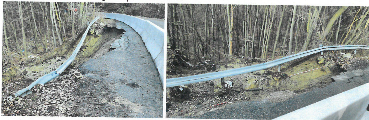
Fotografiile nr. 1 si 2 Imagini de la vizita tehnica din amplasament cu zona afectata (alunecare a parapetului, acostamentului și a unei porțiuni din carosabil)
