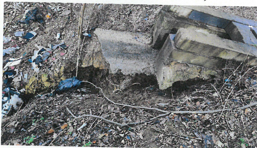
Fotografiile nr. 6 și 7 Imagine de la vizita tehnica (rigolă carosabilă degradată și ravenare)
